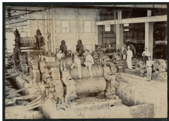
糖廠內壓榨機，以機械取代獸力，大幅提升製糖產量。 國立臺灣歷史博物館 典藏
