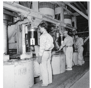
橋頭糖廠，三名工作人員正站在分蜜機前作業。 行政院外交部 提供
