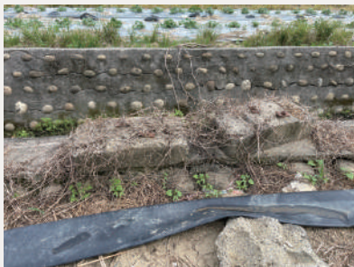
1952年的鋼筋混凝土軌枕
