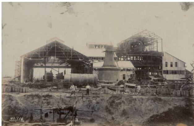
施工中的橋頭糖廠 國立臺灣歷史博物館 典藏
