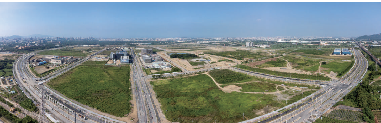
橋頭科學園區腹地空拍景象 洪昭仁 攝影
