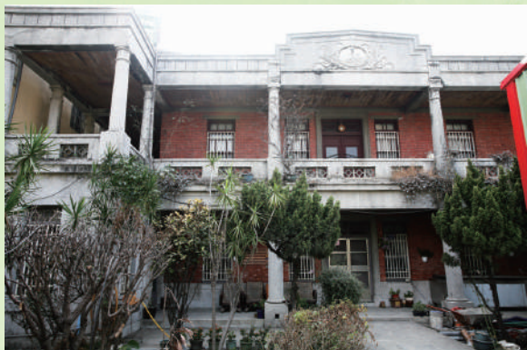
日治楠梓庄庄長（林東來）舊居（攝於2009年） 完工於1911年，二層樓建築加上前庭後院占地廣達約五百餘坪。 陳志鵬 提供
