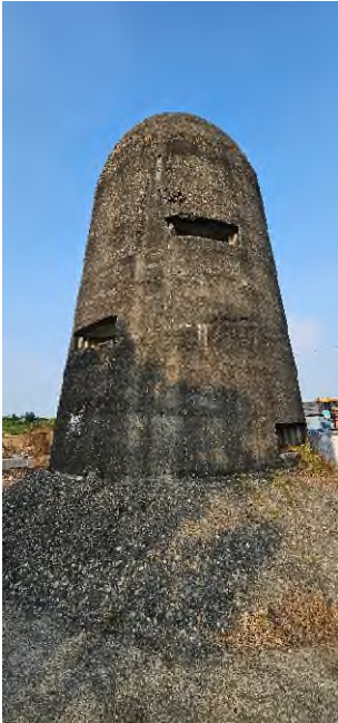
圖 二十九、機槍堡的架槍孔
