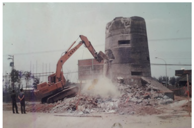
圖 二十五、機槍堡拆除時有軍方人員監視
