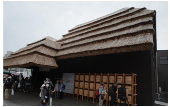
茅草屋展館及門口擺放的大型釀造桶
