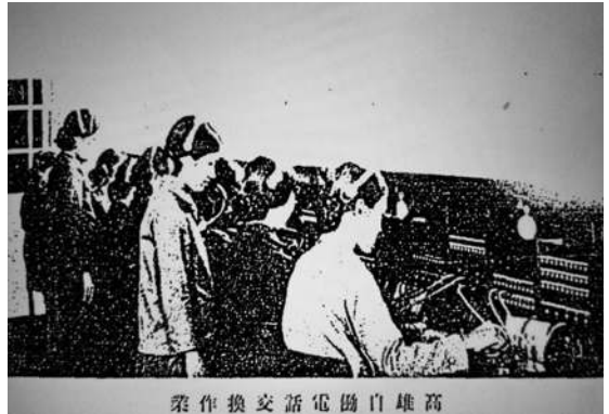
圖 5 高雄自動電話交換作業
