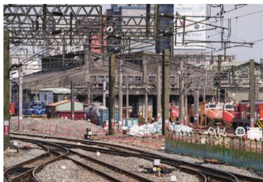
圖 10 原地面層軌道 圖片來源：麥肯諾建築師事務所提供。
