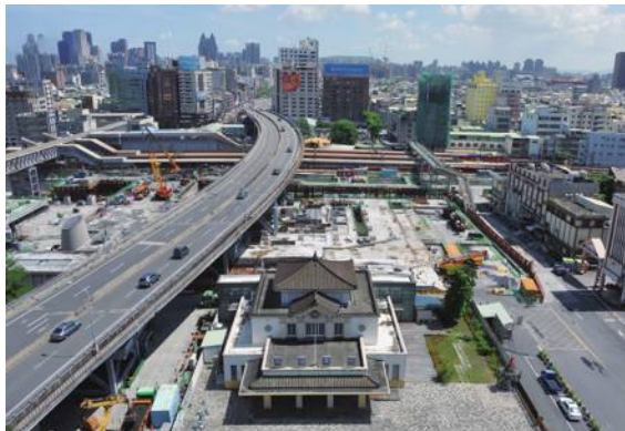
圖 11 暫移於中博高架橋一側的舊車站 圖片來源：麥肯諾建築師事務所提供。
