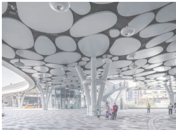
圖 21 傘骨型結構系統支撐天棚
