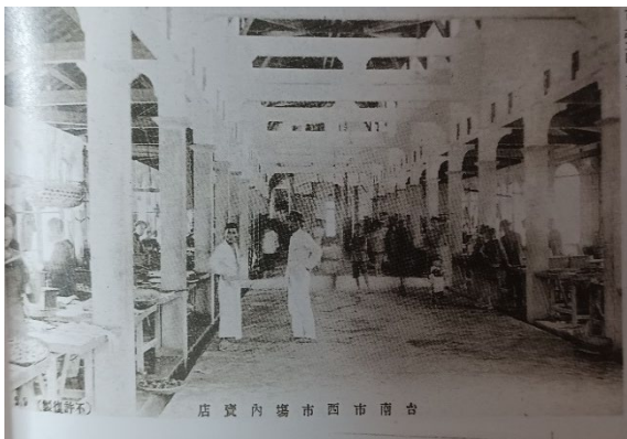
圖 25：大正 9 年(1920 年)時台南西市場內的攤位，可見當時台灣市場內的通風、採光、攤位整齊、混凝土結構的通路、排水溝等，已可比美現代市場。資料來源：松本曉美、謝森展編著：《台灣懷舊》，台北，創意力文化事業有限公司，民國 79 年 11 月初版，頁 167。
