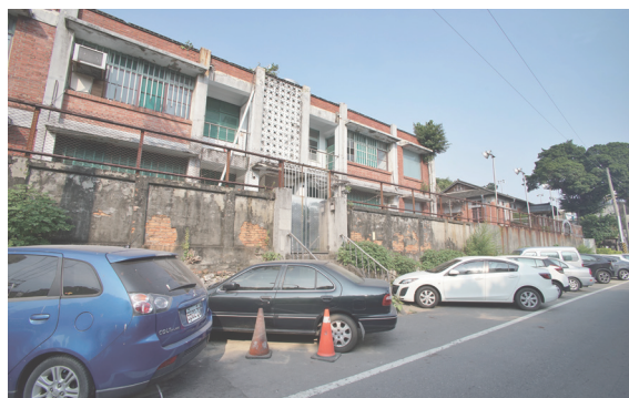
圖 12 原本高雄關職員宿舍（左）與高雄武德殿（右）兩棟磚造建築的有趣對話已不復見
