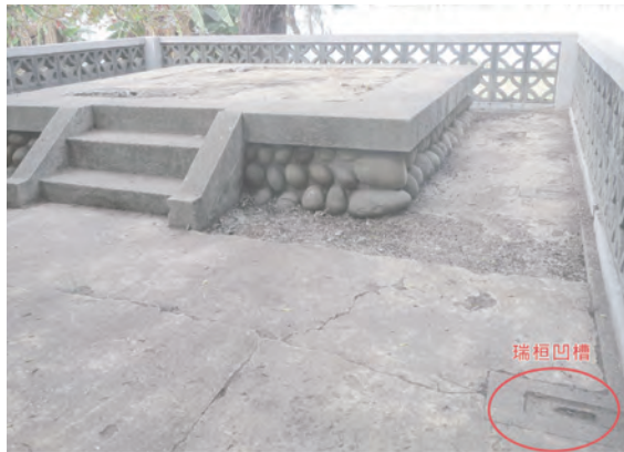
圖 13 第二層平臺外側瑞垣的凹槽 說明：照片中的瑞垣凹槽尚留有鐵條。 圖片來源：廖德宗 2017 年 2 月拍攝。
