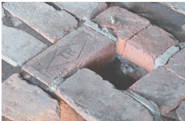
圖 11 中都磚窯廠霍夫曼窯投煤口旁的 TR 磚 圖片來源：莊文韋拍攝於 2022 年 9 月 3 日。
