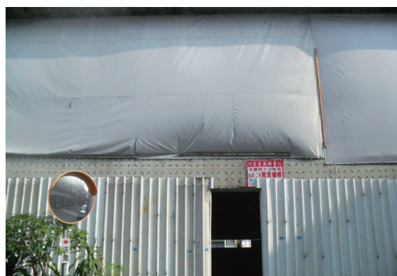
圖9 太陽城西餐廳：一樓中空，懸空的二樓才是餐廳
