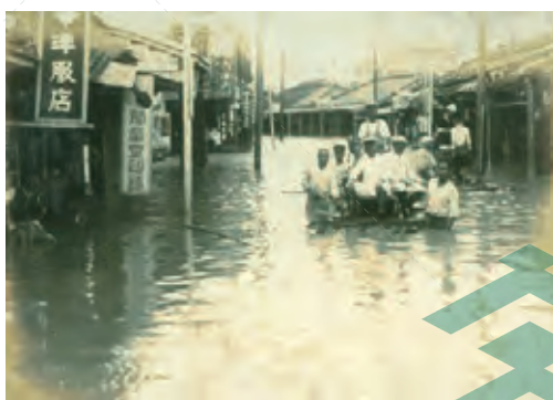
1932 年 3 月 23 日岡山水災，後方可看到太原醫院。 頻繁的水災造成岡山農作物損失慘重。
