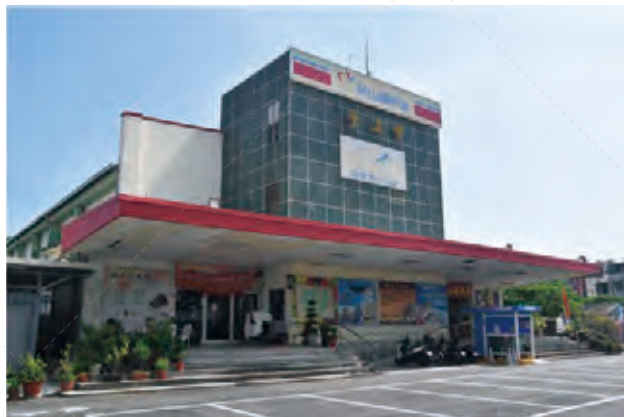
中正堂現況，改為國軍福利站。
