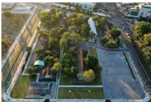
2020 年醒村空拍照，保留周邊綠地，作為開放式公園。可見醒村的「五落仔」五連棟建築。
