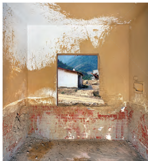
《莫拉克·南沙魯》那瑪夏鄉南沙魯村鞍山巷 72 號 (3) 窗景
