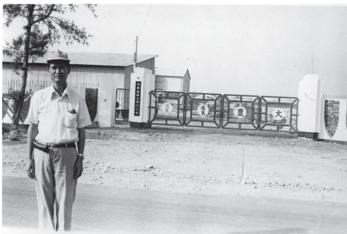
圖2 1975年筆者在岡山鎮大豐液氧工業公司建廠完成留影。（張大邦提供）
