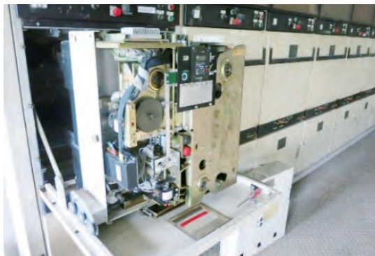
圖 4 GCB 高壓盤檢修 圖片來源：張簡慶豐提供。
