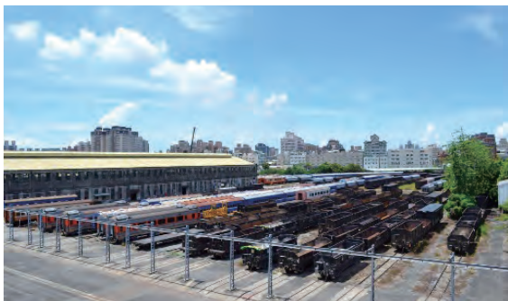
圖 4 2013 年 6 月高雄機廠貨車廠房空拍停車場全貌 圖片來源：張簡坤國提供。
