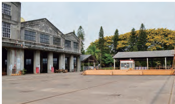
圖 5 高雄機廠行政大樓西側之景觀 圖片來源：張簡坤國提供。
