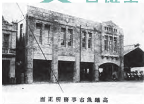
圖 13 高雄魚市株式會社事務所 圖片來源：作者不詳，〈高雄漁港と建その陸上設備〉（臺南：臺南新報社高雄印刷所，1930），附圖。擷取自自治時期全文圖書影像資料系統。
