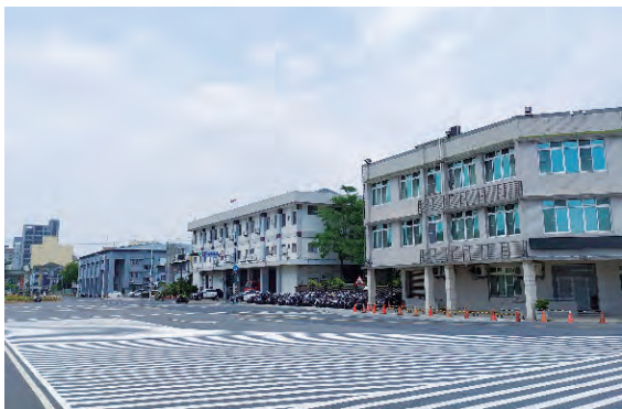
圖 24 建築本體現況
