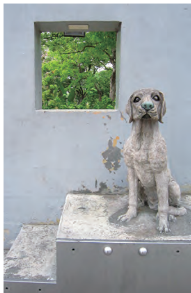
圖5 背景牆面嚴重剝落的「人、狗、梯、門、窗」(蕭伊伶 攝)
