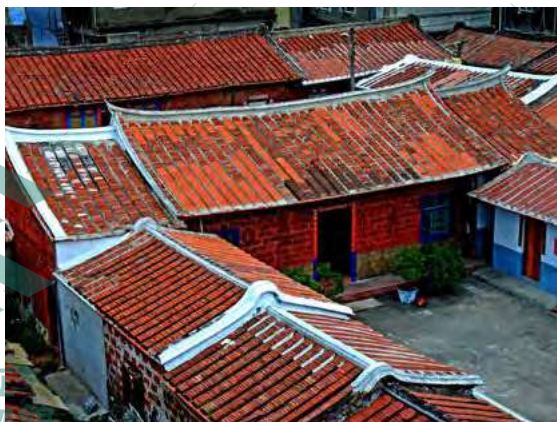
劉家僅存的宗祠，是在城市中能窺探到傳統建築風貌的少數機會。攝影/楊博丞、提供/仁武區公所
