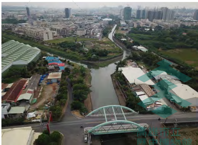
曹公新圳自大樹區九曲堂引流後，向西經過鳥松、仁武，於八埤橋與獅龍溪匯流成後勁溪。 攝影 / 李橙安
