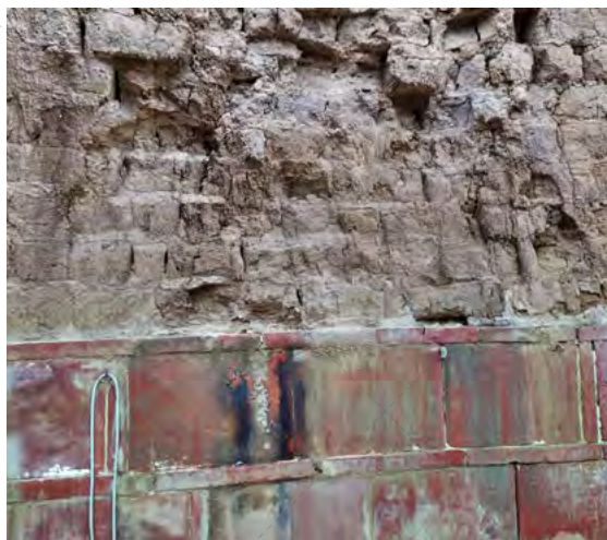
透過部分破損裸露的壁面中，可發現建物本體依然保持土角厝的結構。
