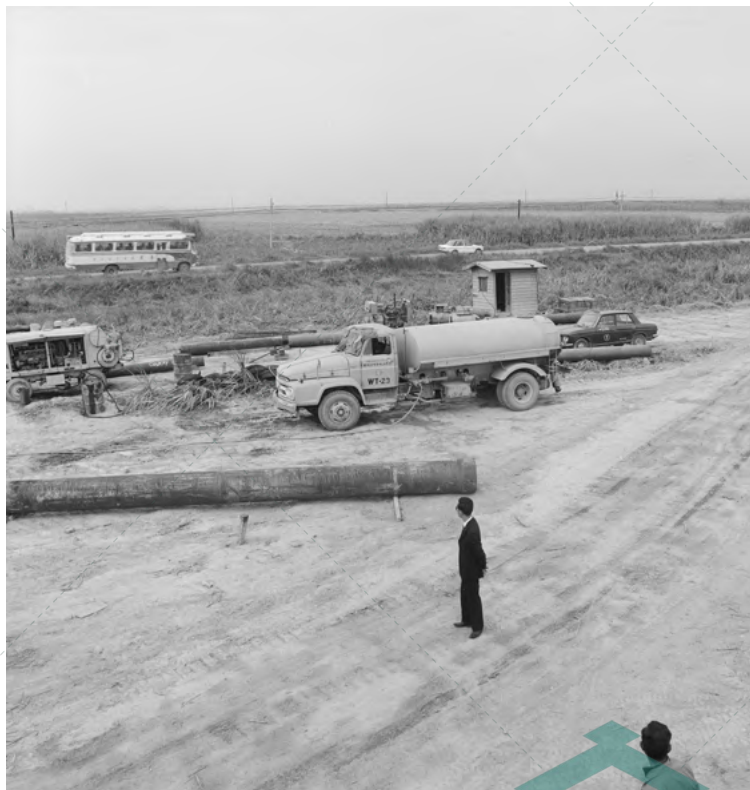
仁武綜合性工業區於 1970 年 6 月開始進行興建工程，圖為當年施工之工程情景。提供 / 外交部
