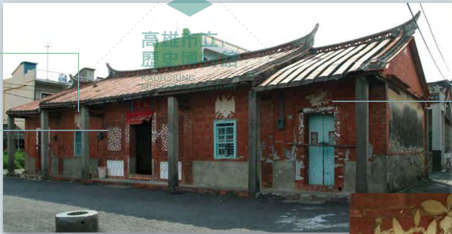
黃家古厝第一進。（照片提供：高雄市政府文化局文資中心）
