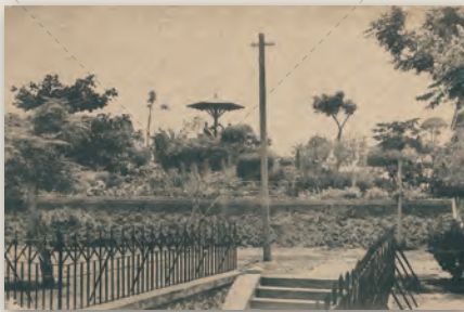
日本政府時期高雄水道淨水池。高雄水源地位於九曲堂原曹公圳入口處，以水道引高屏溪水至打狗山後，先貯存於山腰之淨水池，再行後續配水動作，此為日本人在高雄所施行的上水道（自來水）計畫。
