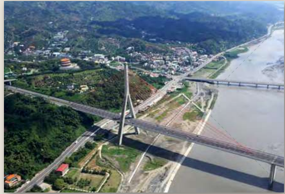
斜張橋。（照片提供：高雄市政府都發局）
