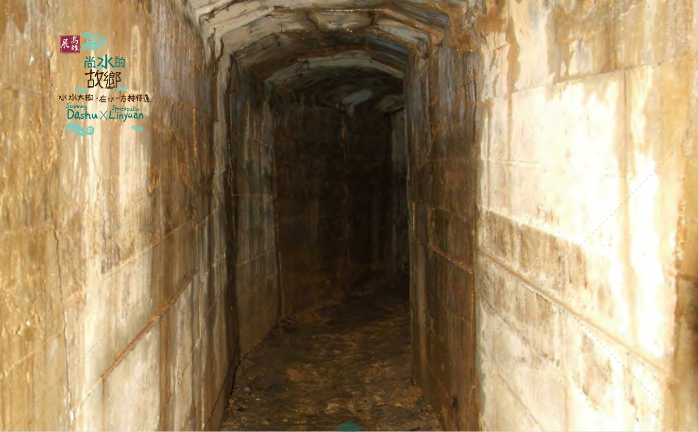
坑道入口。(照片提供：高雄市政府文化局文資中心)
