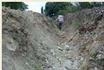
環球水泥舊礦區排水溝。
