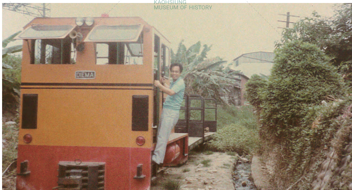
拆除鐵道前的最後列車身影。
