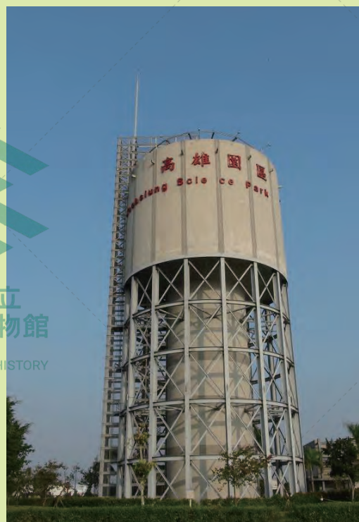
高雄科學園區水塔
