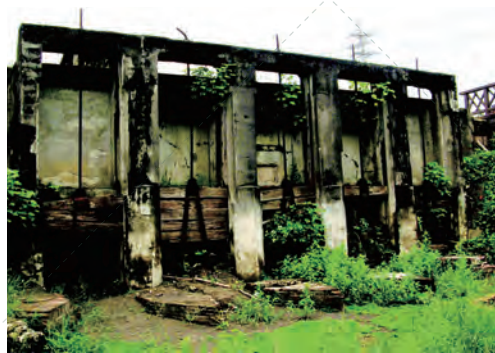
曹公圳舊圳進水口的治水閘門，因有五個進水口，被當地人稱之為「五孔鎖」。
