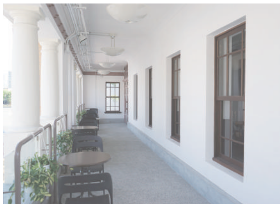
圖 18 二樓內側牆面與開口為三美路商會時期的建築遺構之一（2020）
