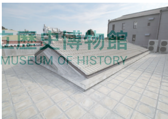
圖 19 舊三和銀行屋頂現況（2021）
