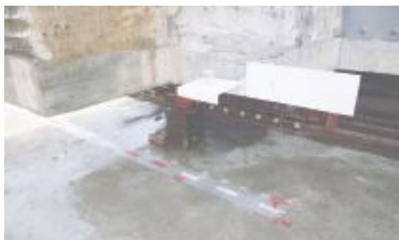
圖 16 2021 年 7 月 26 日開始往北後推 4.8 公尺，平臺上放置一杯水，必須平穩不可外溢（謝明勳攝）
