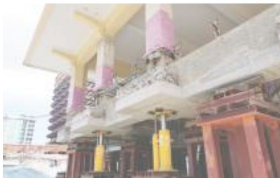
圖 12 帝冠式車站第二階段頂升作業（謝明勳攝）
