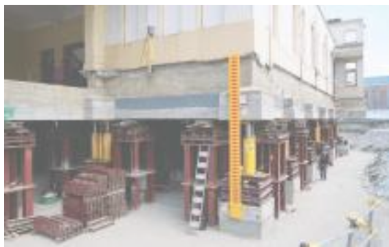
圖 13 帝冠式車站第二階段頂升作業（謝明勳攝）
