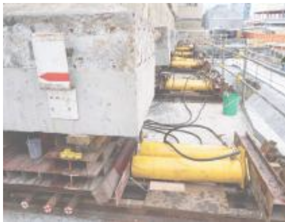
圖 15 站體往西移動時，使用 7 組 210 噸水平推力的油壓千斤頂（謝明勳攝）
