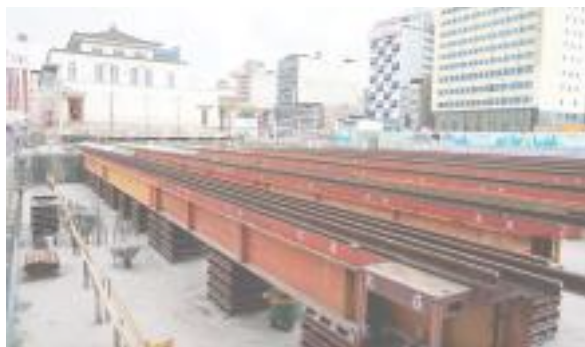
圖 11 帝冠式車站將沿著七路平行軌道，緩緩移動至永久位置，再分段卸降 2.19 公尺（謝明勳攝）
