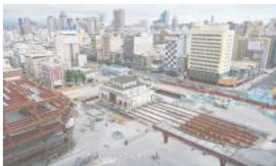
圖 17 帝冠式車站先往北後推 4.8 公尺，7 月 28 日抵達第一次定位（謝明勳攝）
