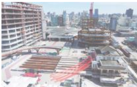
圖 21 2021 年 8 月 22 日帝冠式車站開始往西遷移，9 月 26 日到達定位，回到中山路 / 博愛路的都市中軸線（謝明勳攝）
