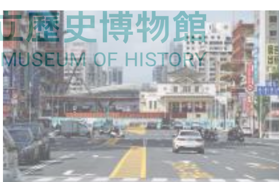
圖 19 9 月 14 日，正從東往西移動中的帝冠式車站，即將歸回都市中軸線永久定錨（謝明勳攝）
