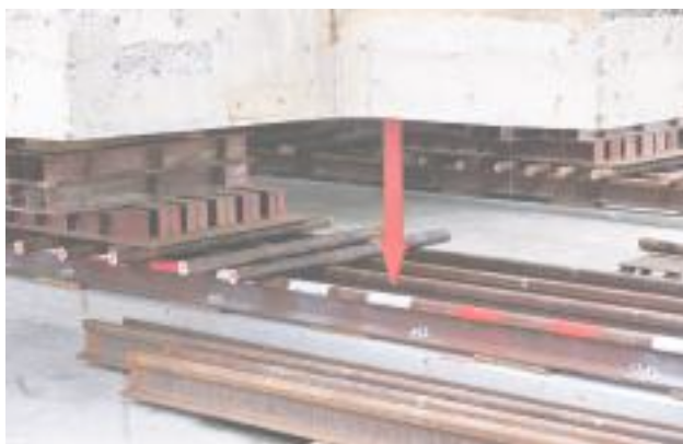
圖 14 基礎下方的移動裝置及標示標尺的鋼軌，每次移動距離為 70 公分（謝明勳攝）
