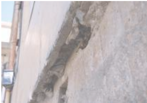
圖 32 高雄火車站外牆石磚 (ストーンブロック)・固定在結構體上之樣貌 (蔡侑樺 2021 年攝)
