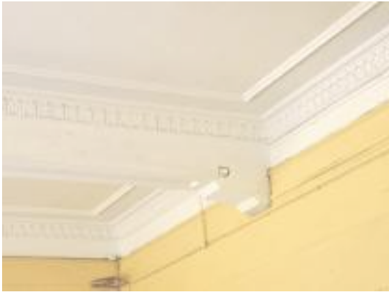
圖 42 高雄火車站玄關鋼筋混凝土梁，依文獻記載，表面係施以苦灰石石膏（ドロマイドプラスター）塗佈，再以棉布團上油漆，梁板間之線腳裝飾則為印花石膏貼附（蔡侑樺 2018 年攝）
