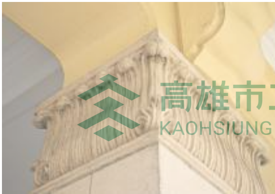
圖 33 高雄火車站玄關立柱及柱頭之石磚 (ストーンブロック) 裝修 (蔡侑樺 2018 年攝)
