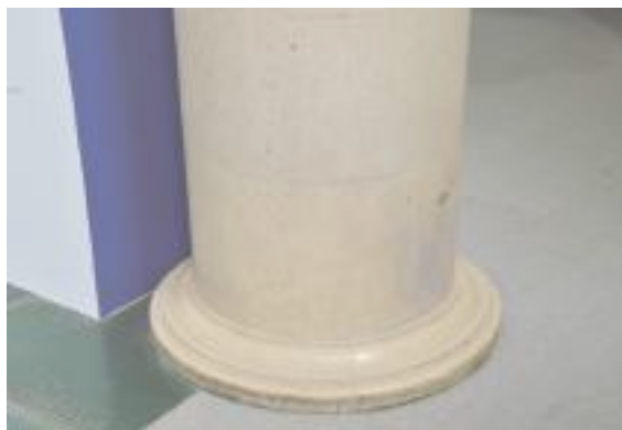
圖 40 高雄火車站廣間圓立柱與柱礎，為人造大理石裝修（蔡侑樺 2018 年攝）
