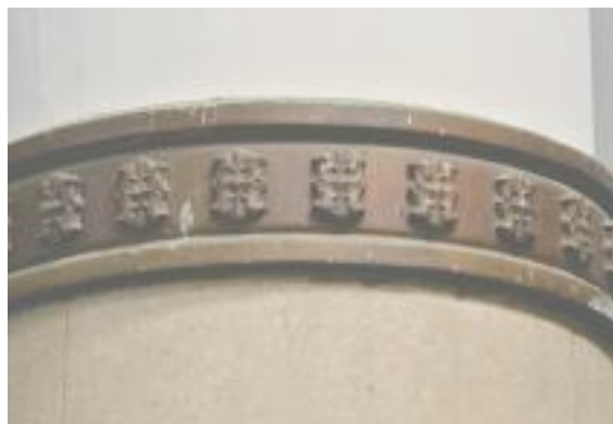
圖 41 高雄火車站廣間圓立柱上的裝修飾帶，依文獻記載應為鋁合金（蔡侑樺 2018 年攝）
