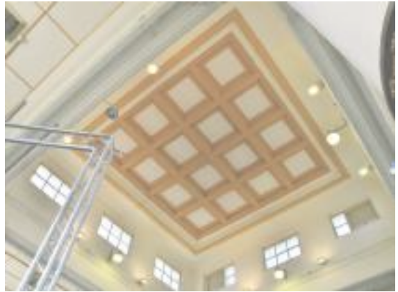
圖 43 高雄火車站廣間木摺天花板，依文獻記載，其頂板由纖維板構成（蔡侑樺 2018 年攝）。
