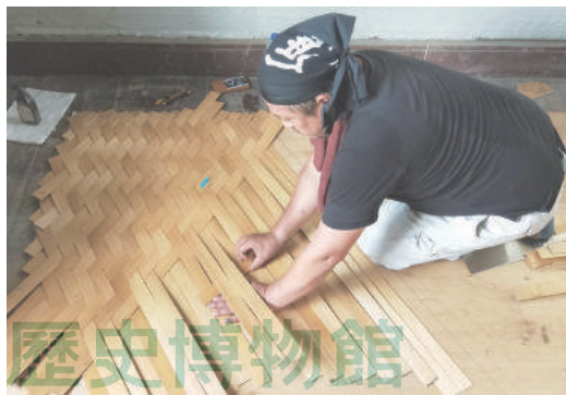
圖 30 網代天井的編織作業 圖片來源：陳啓仁提供。
