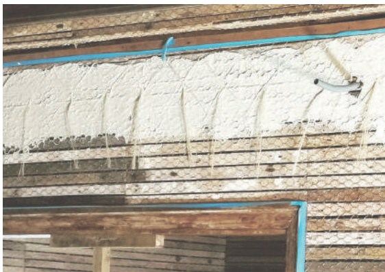
圖 37 壁面左官中的麻筋補強 圖片來源：陳啓仁提供。
