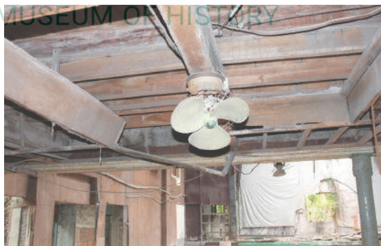
圖 2-3 西螺戲院內部設備
