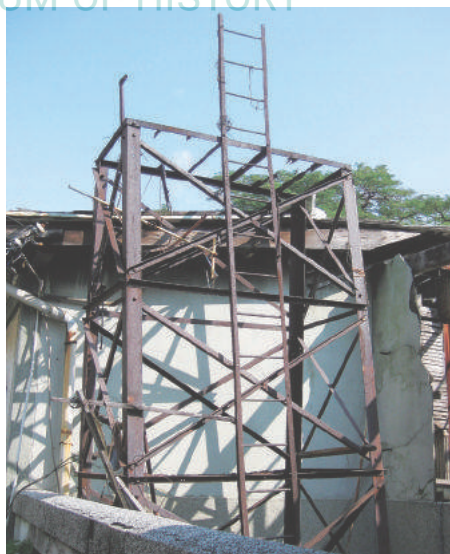
圖 25 逍遙園水塔的鋼架與鐵梯 圖片來源：楊玉姿攝於 2010 年。
