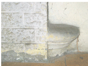
圖 28 防撞緣石設計有向內傾斜的凹坑
