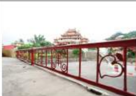
前臺鑄鐵欄杆
