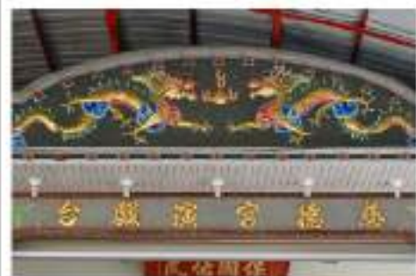
立面簷部矮牆近景
