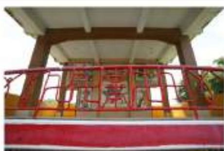
前臺鑄鐵欄杆
