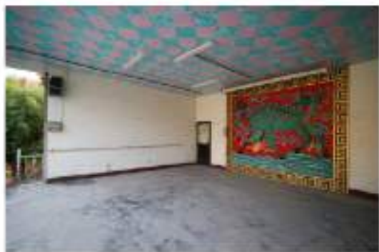
【圖 5-38】小港鳳騰宮戲臺反梁屋頂
