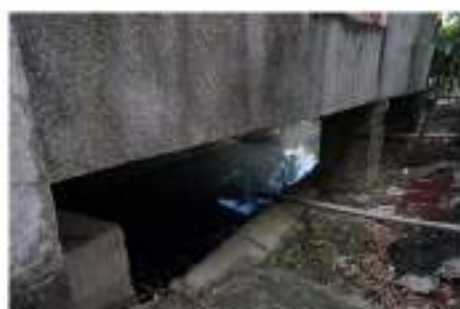
戲臺下方水溝
