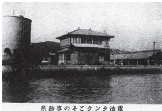
圖 10 重油儲存槽及重油事務所
