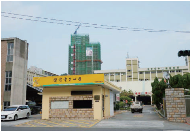
圖 10 台灣電力公司高雄辦事處 照片出處：作者拍攝。
