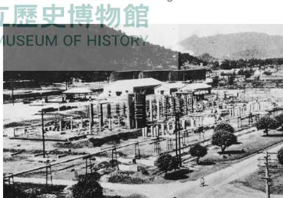
圖 17 高雄煉油廠之第一蒸餾廠景觀
