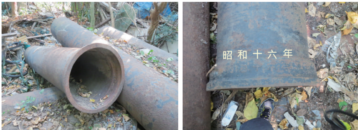
圖 3-11 西自助新村樹林內的鑄鐵管
