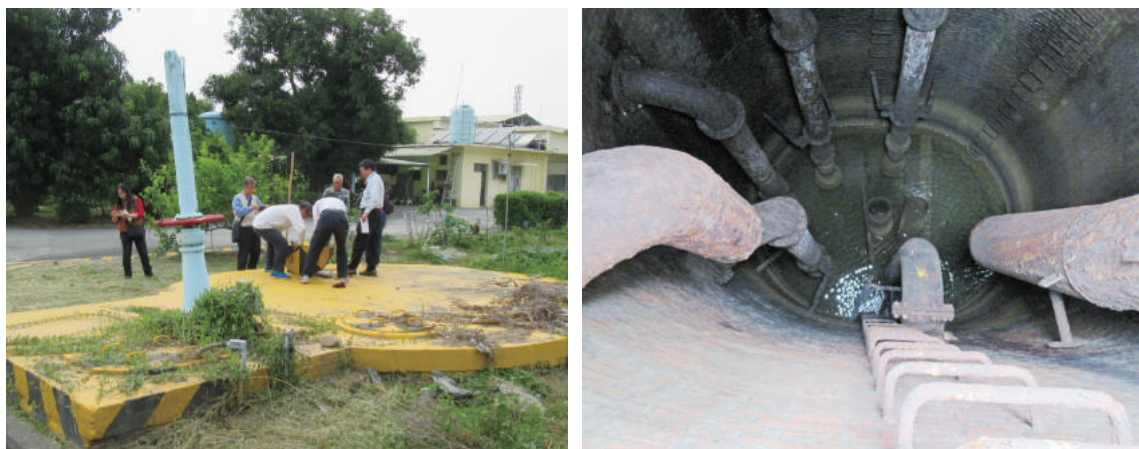
圖 4-2 大寮水源站集水井的外部及內部
