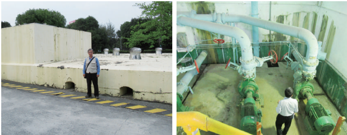
圖 4-3 大寮水源站的耐彈式唧筒場及內部
