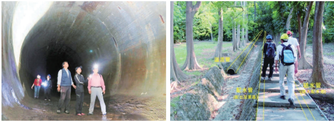
圖 3-10 半屏山配水池的內部及外側登山步道
