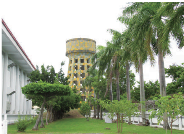
圖 5-4 岡山空軍基地的高架水塔
