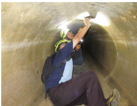
圖 4-8 日本陸軍鳳鼻頭陣地在林園沿海公路下方的鋼筋混凝土管
