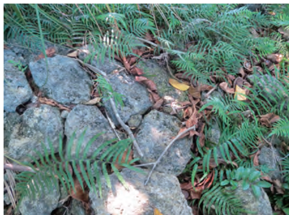
圖 3-3 壽山館後方山坡的砵砵石駁坎與登山步道旁的涼亭殘跡 資料來源：廖德宗拍攝。
