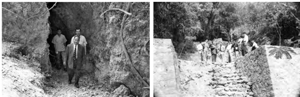
圖 3-11 陳武璋市長 1959 年 3 月巡視壽山公園整建工程
