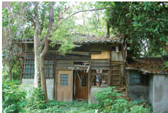
圖 4-7 鳳山醫院東側小路旁，2007 年尚有一日式宿舍，現已拆除，研判為神職宿舍。
