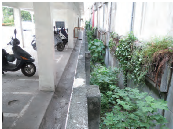
圖 4-2 鳳山神社基地南側石垣，機車格與消防隊中間的石牆，高度 1.2 公尺。
