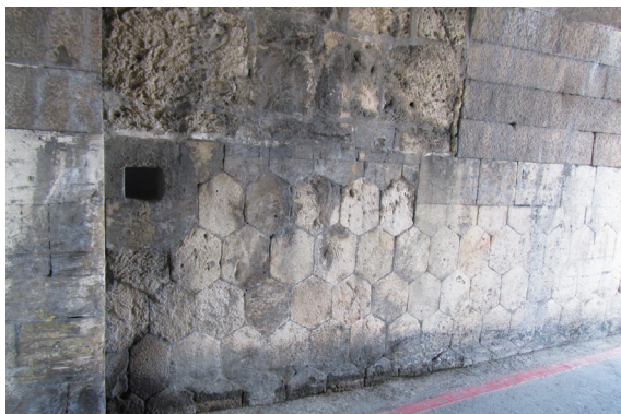
圖版 9 北城門六角蜂巢狀堆石與尖錐平底狀咾咕石基礎
