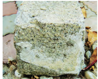
照片 15 （上圖）拱卷上面較不平整
