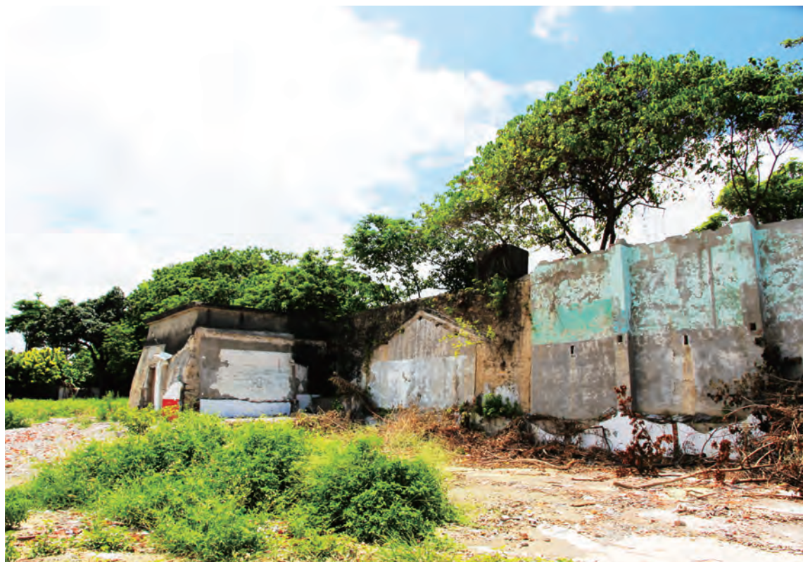
照片 20 西門段砲台外貌 資料來源：黃朝煌攝
