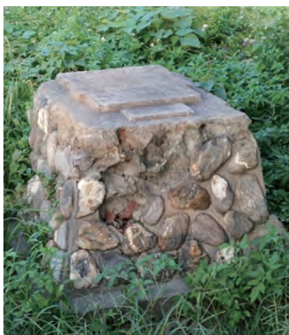
圖 44 震洋神社基座上方承接木造建築之樣式 資料來源：陳啟仁拍攝
