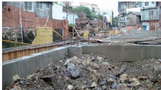
埤北里建造透天厝，並發現柏油路下為厚度約 30-50 公分的咾咕石牆
