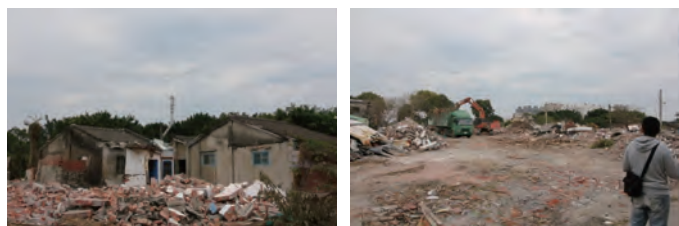
圖 20 2014 年 2 月國防部拆除工程進行中 資料來源：陳啟仁拍攝
