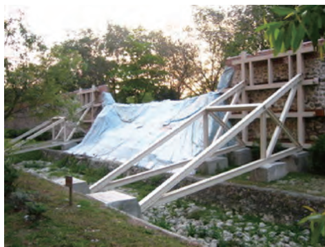
緊急加固現況（靠近放置砲臺區段）
