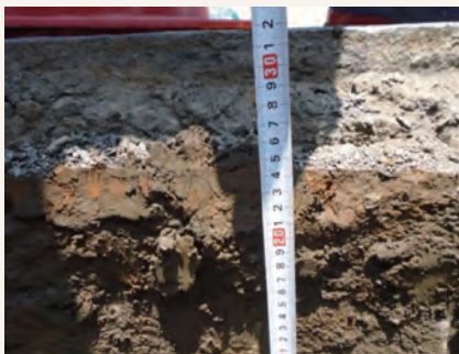
井緣至混凝土及孔蓋厚度約 6 公分
