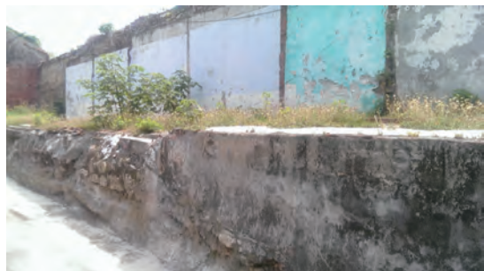
左營大路四巷之殘存城牆與馬道
